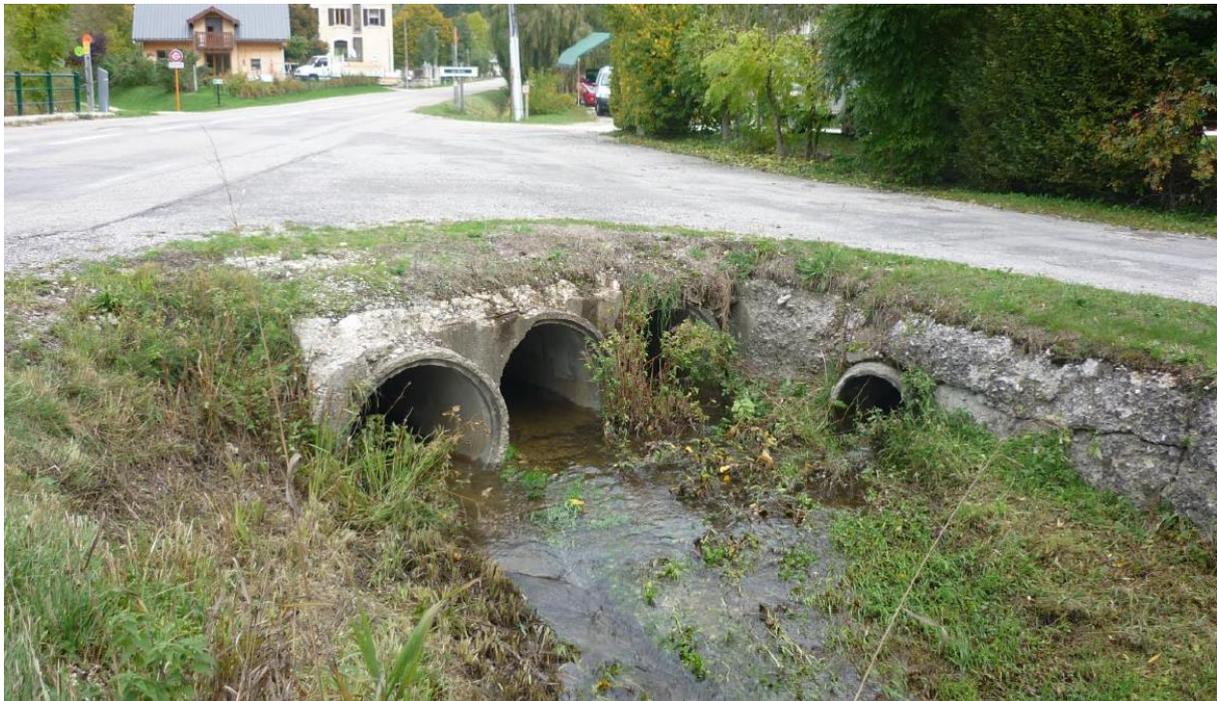
L'ouvrage actuel composé de trois buses de 1 mètre de diamètre sera remplacé par un pont cadre de 4 mètres de large et 2 mètres de hauteur, ce qui facilitera l'écoulement des eaux et supprimera l'obstacle que constituent les buses pour la faune piscicole.
